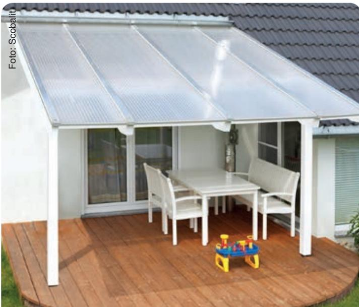
Überdachung mit Acryl-Stegdoppelplatten
