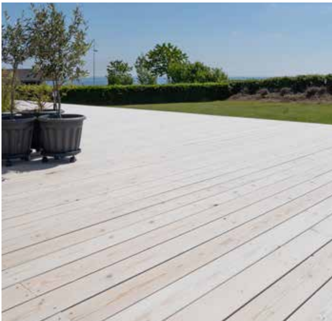
Sature Terrasse frisch verlegt
