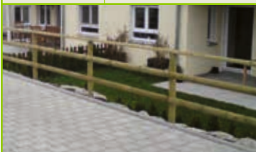
Pfähle KDI* zylindrisch gefräst, Kopfende gefast
