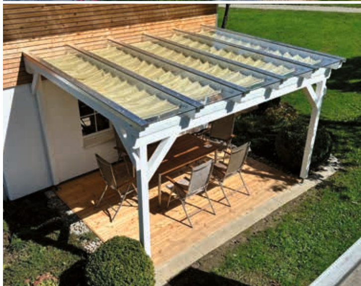
^ Pergolaüberdachung mit Terrassendielen aus Douglasie
