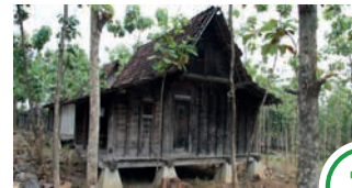
Abriss des Holzhauses
