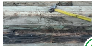
Entfernen von Nägeln, Schrauben und anderen Verbindungselementen
