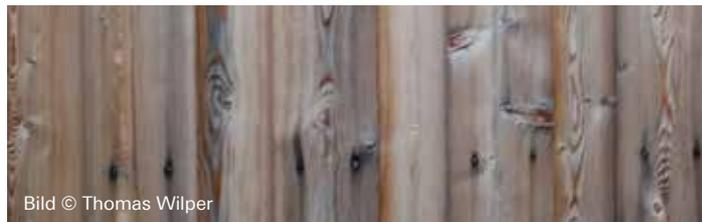
Diese Verschraubung wurde mit C1-Schrauben (martensitisch) ausgeführt und bei Kontakt mit den Inhaltsstoffen der Lärche ist es zu einer Schwarzfärbung gekommen.
