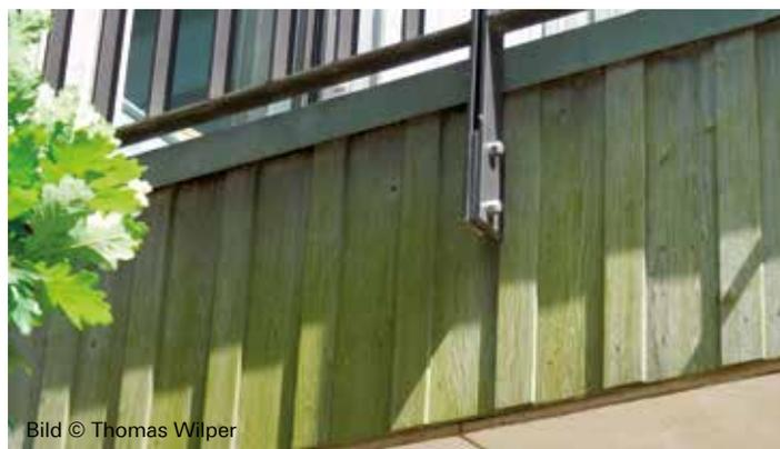
Auch auf NFC-/WPC-Profilen, Faserzementplatten, UPB, HI-MACS, Laminam sowie HPL-Platten ist Grünbelag oder eine Verunreinigung durch Staub- und Schmutzablagerungen möglich. Dies kann den Farbton der Fassade optisch verändern, insbesondere an stark befahrenen Straßen können durch Rußablagerungen deutliche Farbunterschiede auftreten.
